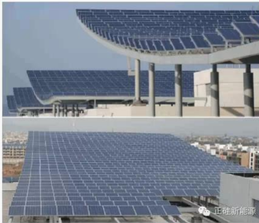
在商业建筑屋顶上的典型应用：浙江义乌小商品城 1.3MWp 光伏系统
